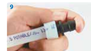
9 Быстро выньте инструмент из трубы и установите фитинг Q&E. Конец трубы при этом должен упереться в упор фитинга
